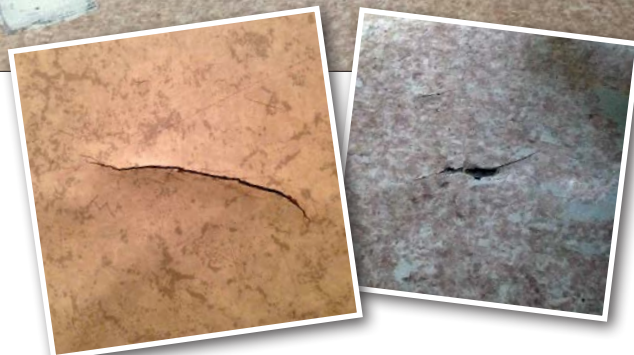
Golven är i mycket dåligt skick efter 25 års slitage.
