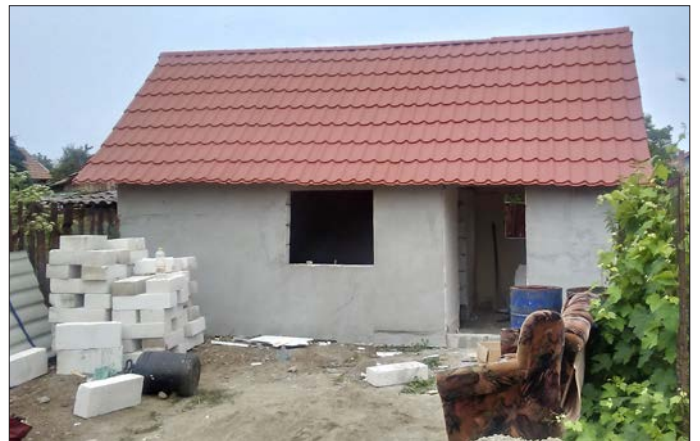
Katy har med hjälp av sin familj och pengar från oss byggt ett litet hus på den tomt hon vill köpa av sin granne.
