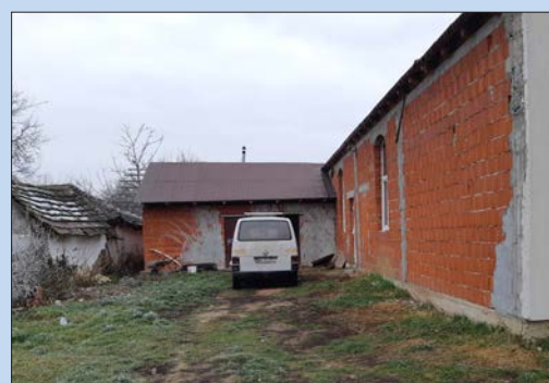
Församlingen i Batar räknar med att snart börja bygga toaletter till sin nya möteslokal.
