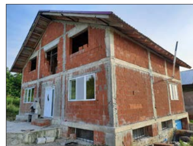
Mycket återstår innan huset är färdigt. Huset har nu isolerats utifrån.
