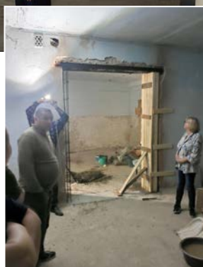
Vi står i det rum som skall bli det nya bageriet. Den nuvarande platsen skall bli en församlingsvåning/matsal. Tillfälliga hål har tagits för att kunna flytta utrustningen från ett rum till ett annat.
